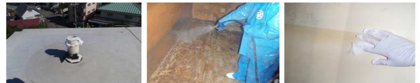
写真 1. 貯水槽内・外部の写真
