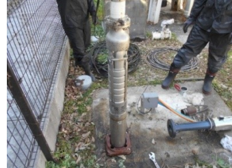
既設ポンプ引揚
