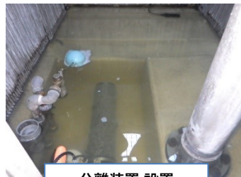
分離装置 設置
