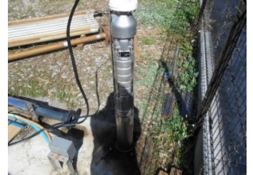
新ポンプ設置
