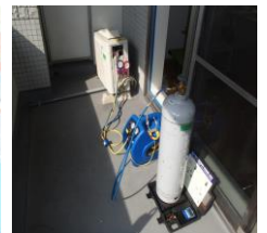
冷媒ガス回収
