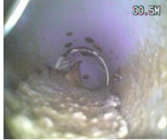
排水管内点検
