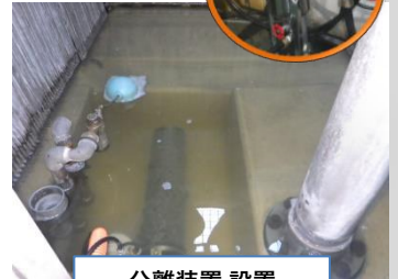
分離装置 設置
