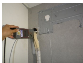
発生箇所の測定
