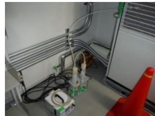
腐食性ガスサンプリング
