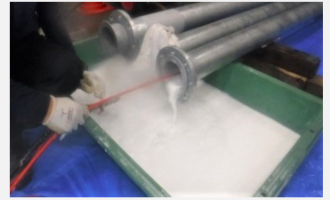
薬品洗浄及びフラッシング作業
